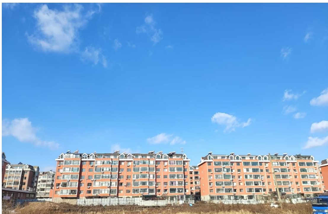
北侧-东平大街 3 期居民楼
