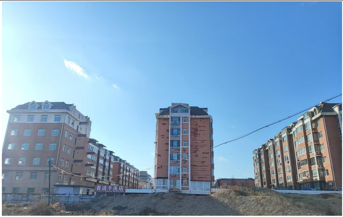
西侧-东平大街 2 期居民楼
