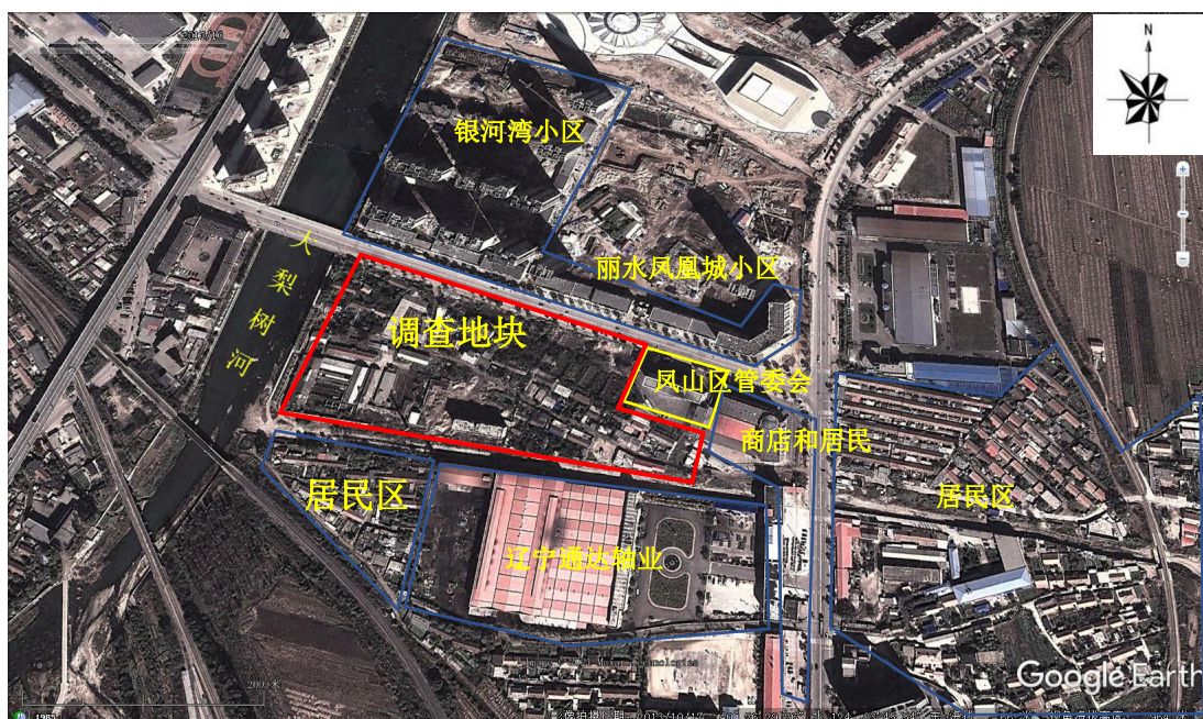
图 3-41 2011 年 5 月 15 日谷歌地球显示该地块 (最早的历史影像, 地块周边主要以居民为主, 工业企业为南侧辽宁通达轴业)
