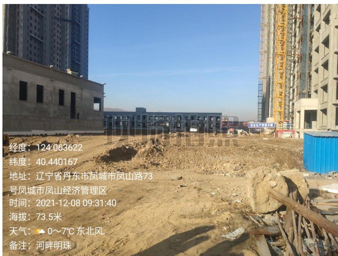
图 3-9 项目河畔明珠 C 区一期地块现场照片
